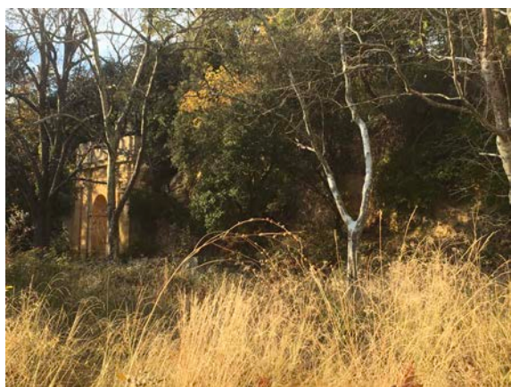
Fig. 25. Parc à l'abandon, sur la route du Tholonet. Saint-Marc-Jaumegarde (Bouches-du-Rhône). Cliché Y. Cranga, 2017.
